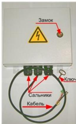
Электромонтажный шкаф имеет степень защиты IP 54 и предназначен для установки в уличных условиях.
