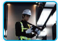
[ Настройка угла положения камеры в лифте ]
