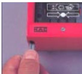
Для тестирования сигнализации с извещателями типа WR2001/SR и WR2072/SR-470 используется специальный ключ, поставляемый в комплекте. Когда ключ вставлен в ИПР, стекло опускается, имитируя его разрушение, и извещатель активизируется.
