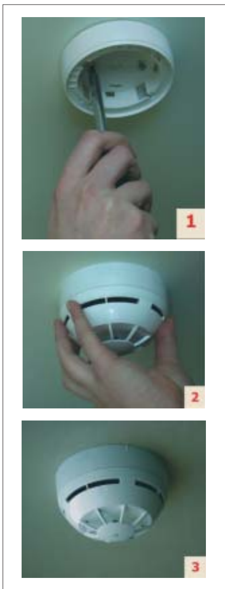
Фото. Установка одного радиоканального извещателя занимает не более минуты
