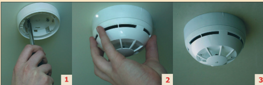
Фото. Установка в помещении одного радиоканального адресно-аналогового пожарного извещателя "Аврора-Р" занимает несколько минут
