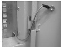
3. Включить вводной автоматический выключатель, расположенный на левой боковой стойке шкафа комплекса.
