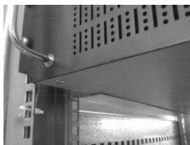
1. Разместить на направляющих шкафа ИБП и закрепить его винтами (входят в комплект поставки).
