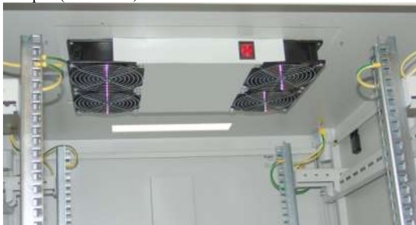
Установленный вентиляторный блок в шкафу
