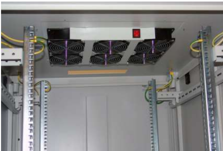
Установленный вентиляторный блок TLK-FAN6-GY в шкафу
