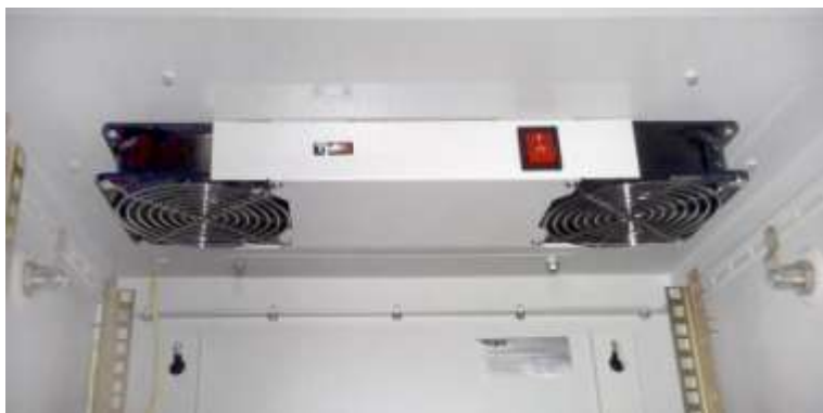
Установленный вентиляторный блок в шкафу
